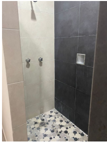
Regadera espaciosa con cubierta de ceramica Spacious shower ceramic covered
